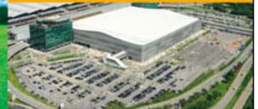
Building Construction 樓宇建築 Hong Kong International Airport SkyPlaza 香港國際機場天璣
