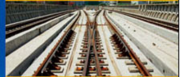
Trackwork Engineering 路軌工程 East Rail Ma On Shan Extensions 東鐵馬鞍山綫
