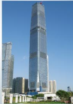
International Commerce Centre 環球貿易廣場
